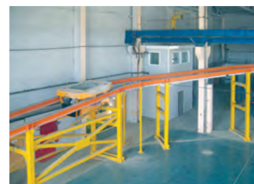
АДРЕСНАЯ ПОДАЧА БЕТОНА
